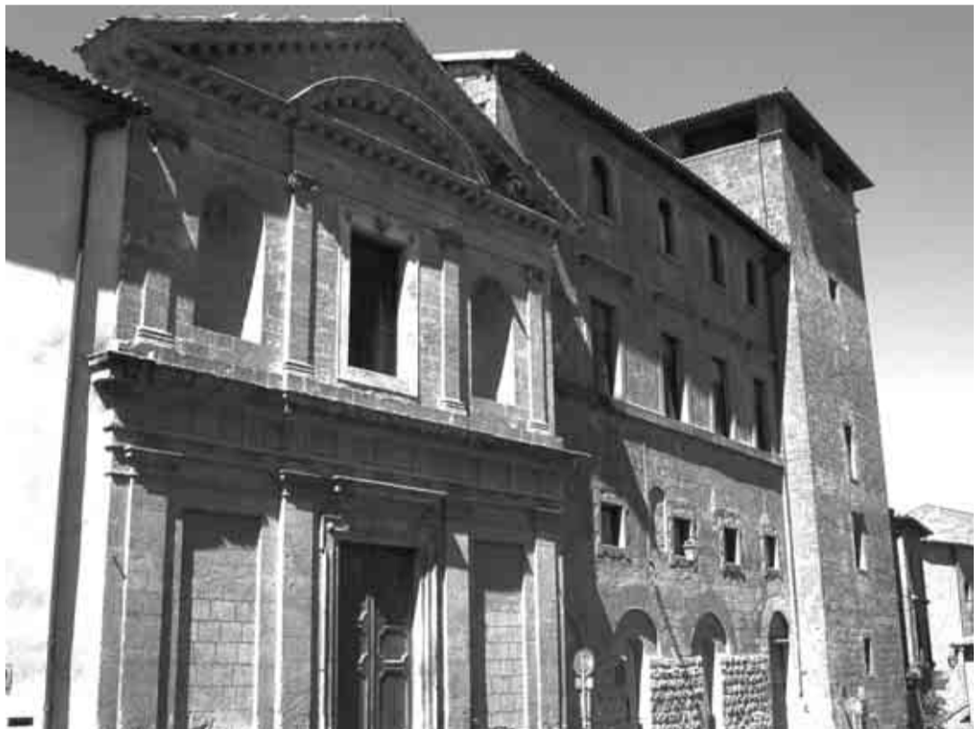
Casa e Torre de' Ranieri e chiesa di San Ludovico in Piazza Ranieri in Orvieto
